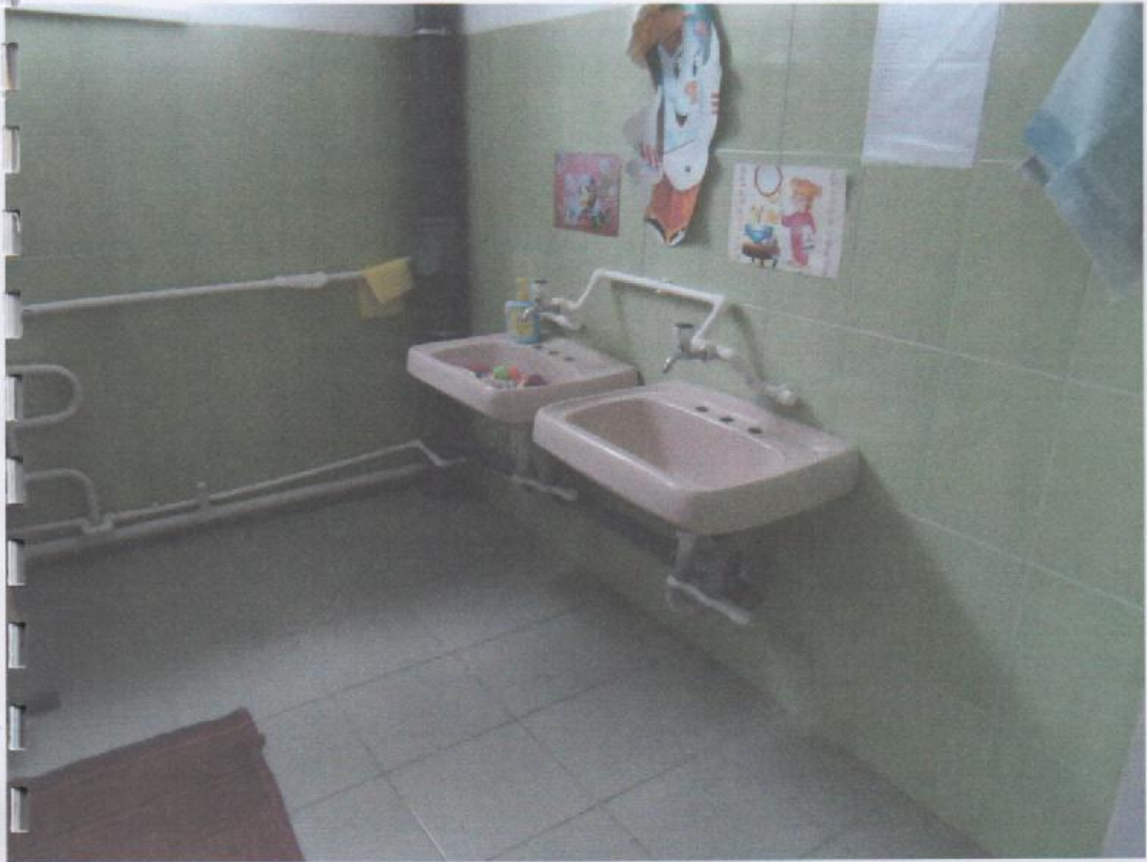
Фото № 10 Туалетная комната (умывальники)
